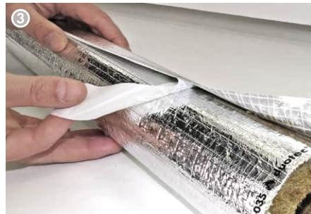
Schutzfolie der werkseitig aufgebrachten, selbstklebenden Überlappung abziehen und Längsschlitzung verkleben.
