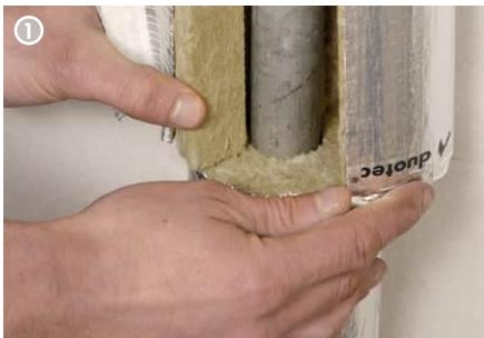
Die Rohrschale mit Aluminium-Kaschierung ist einseitig geschlitzt und lässt sich durch Aufklappen um das zu dämmende Rohr legen.
