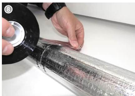
Querstöße der Schalen sind fugenfrei zu verlegen und zusätzlich mit geeignetem Klebeband des Herstellers zu sichern. Klebebänder generell mit Isolierspatel glatt und fest andrücken.
