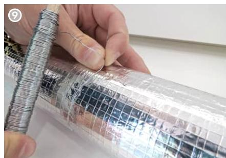
Die Rohrschale ist zusätzlich mit weichverzinktem Bindedraht zu sichern. duotec: min. 6 Umlwicklungen pro Meter; steinwool: 5 Umlwicklungen pro Meter.
